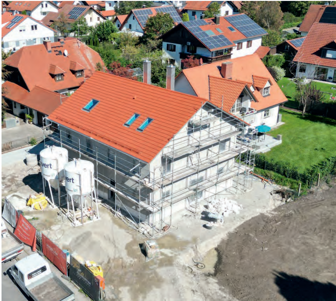
Rohbauphase - inzwischen sind die Ziegel eingedeckt und die Fenster eingebracht.
