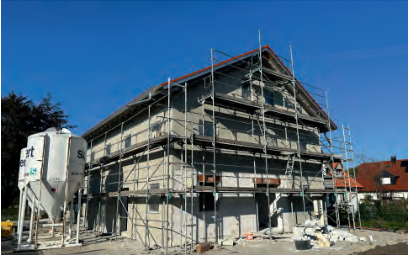
Rohbau mit Fenstern und gedecktem Dach, September 2023 - Süd-West-Ansicht
