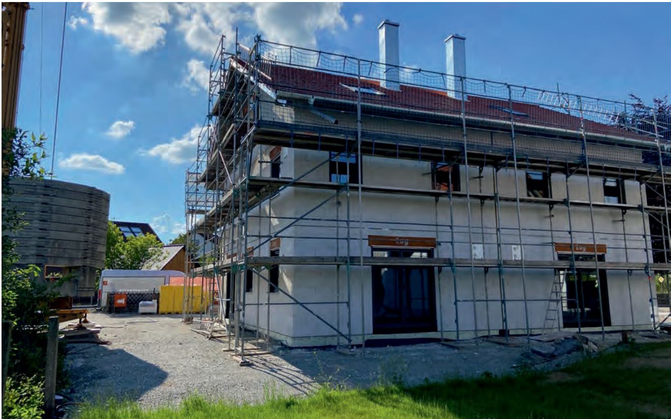
Rohbau mit Fenstern und gedecktem Dach, Juni 2023 - Süd-Ost-Ansicht
