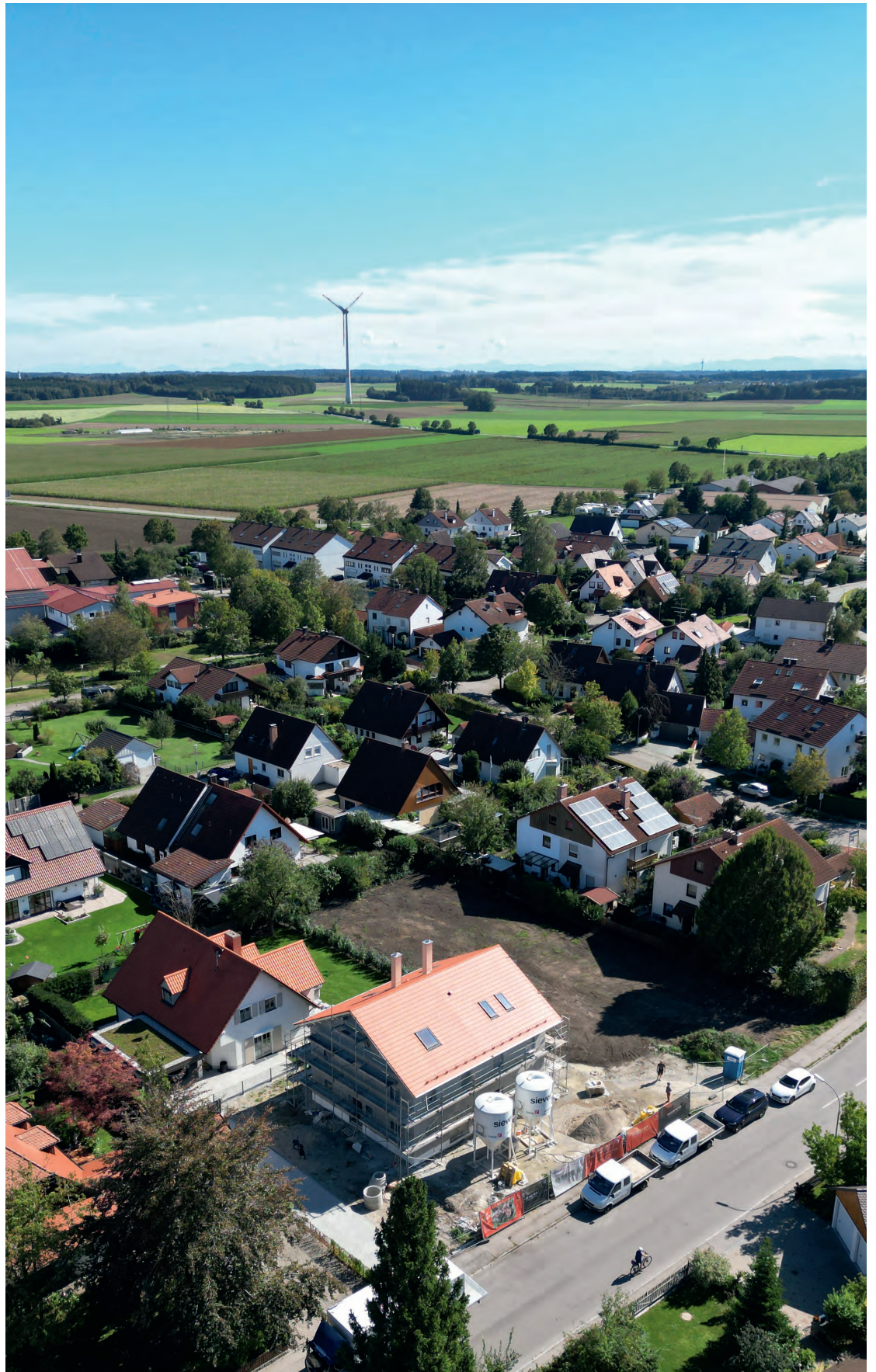
Der Außenputz steht kurz bevor
